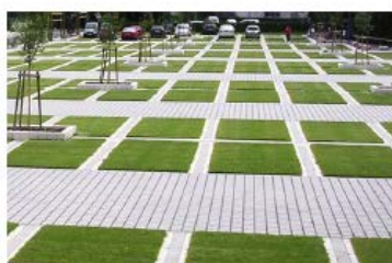
Exempel på hur man kan arbeta med grönska och infiltration på parkeringsytor.
