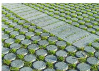
Exempel på hur man kan arbeta med grönska och infiltration på parkeringsytor.
