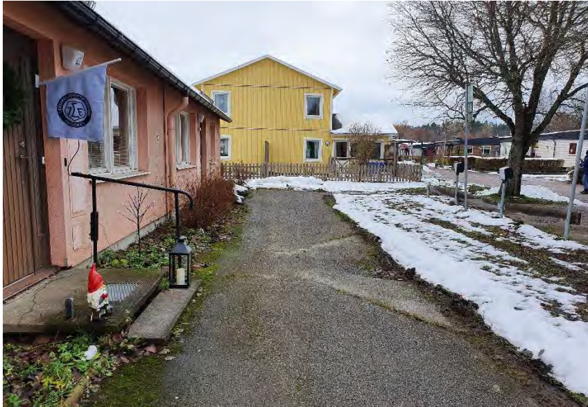
Figur 12. Observerad dagvattenbrunn inne på fastigheten. Hängränna och stuprör som leds direkt ned i marken. Då fältbesöket genomfördes på vintern då det låg snö på marken, var vattenmättade områden och stående vatten svårare att notera. Dessutom kan brunnar och trummor potentiellt ha legat gömda under snön.
