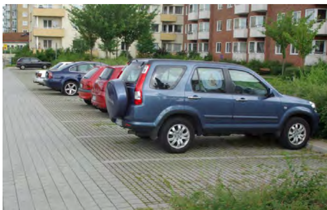
Figur 17. Till vänster: Exempel på gräsarmerad betongbeläggning på parkeringsplats (Foto: WRS). Till höger: Principsskiss för genomsläpplig beläggning. Ytan byggs upp med ett bärlager av grov makadam i botten, eventuellt överlagrad av ett förstärkningslager och slutligen vald beläggning, i detta fall gräsarmerad betonghålsten (Illustration: VA-guiden).
