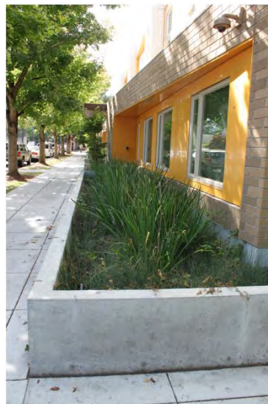
Figur 16. Till vänster: Principskiss över en regnbädd och stuprör med utkastare (Illustration: VA-guiden). Till höger: Exempel på en upphöjd regnbädd (Foto: WRS).
