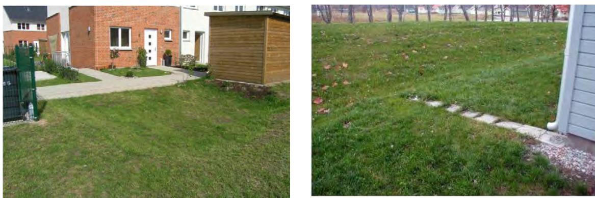
Figur 15: Olika exempel på infiltration i en vanlig grönyta. Till höger: Vattnet leds till grönytan på bred front. Ytan kan också göras skålförmad. Till vänster: Exempel på hur takvattnet leds till grönytan (Bilder: WRS).
