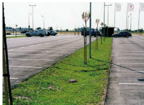
Figur 18. Till vänster: Principskiss av ett makadamdike uppbyggt med dräneringslager med makadamfyllning, övergångslager, matjord och gräs (Illustration: VA-guiden). Till höger: Exempel på ett infiltrationsstråk vid en parkeringsyta (Bild: VA Syd).
